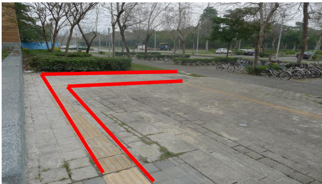
無障礙坡道不得設置導盲磚或其他妨礙輪椅行進之鋪面，並應採用堅固、防滑之路面材質。
